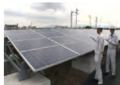
太陽光パネルの外観検査
